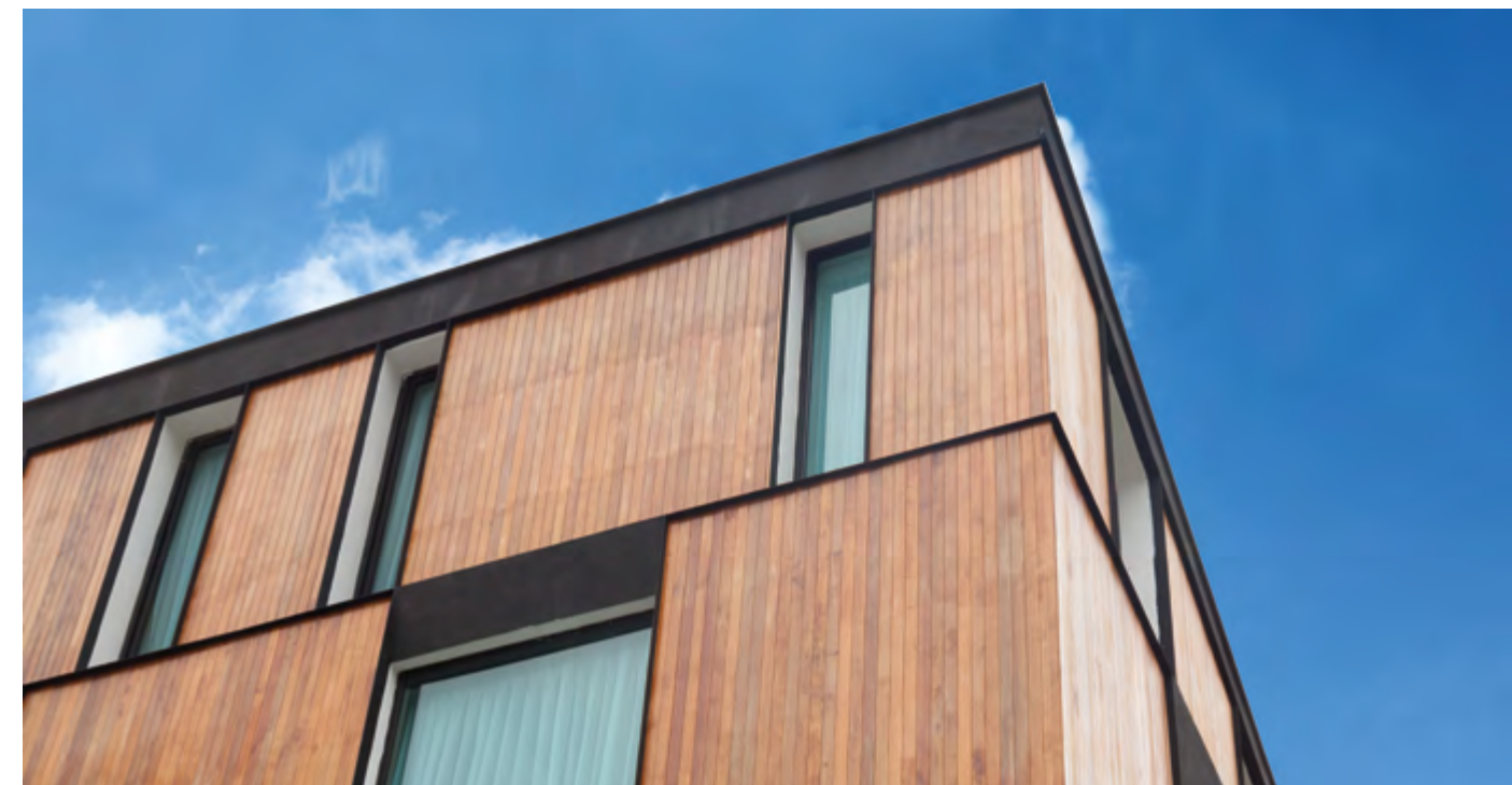
Ipé appena posato Just laid Ipé
