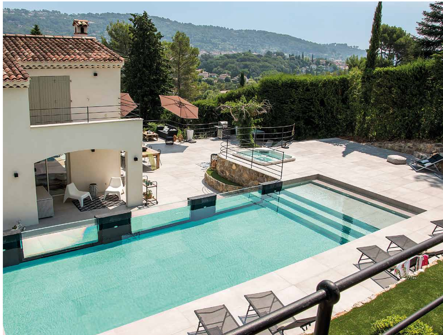
STAIRWAY, POOL EDGE AND FLOOR Prima Materia Cenere 2.0 60x120
